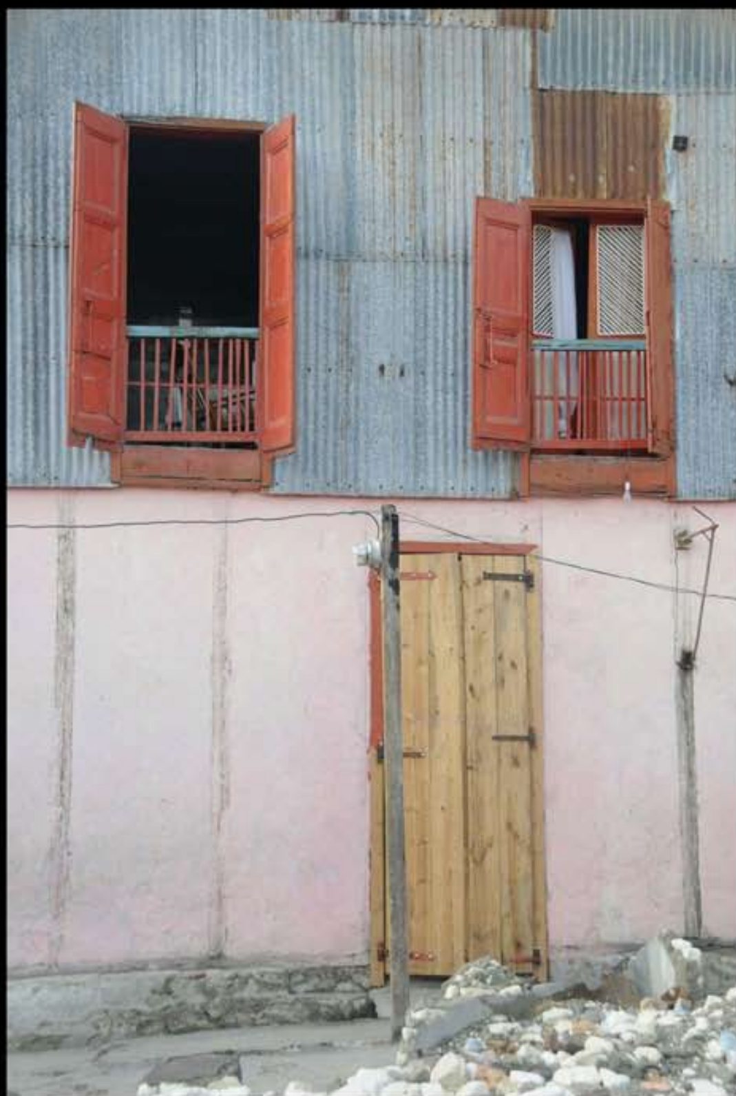
Détail des ouvertures de la façade latérale Nord
