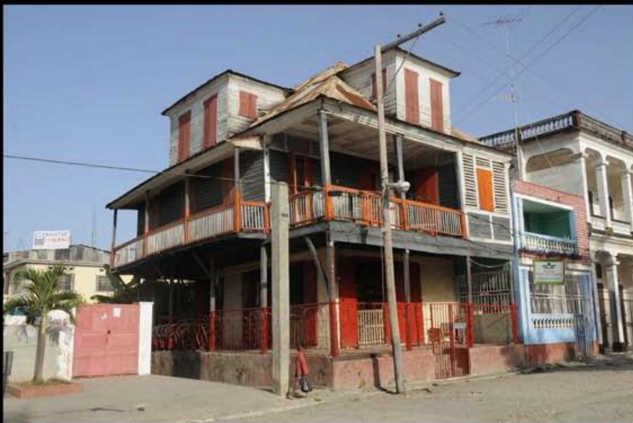
La façade principale donnant sur la place des Trois-Dumas
