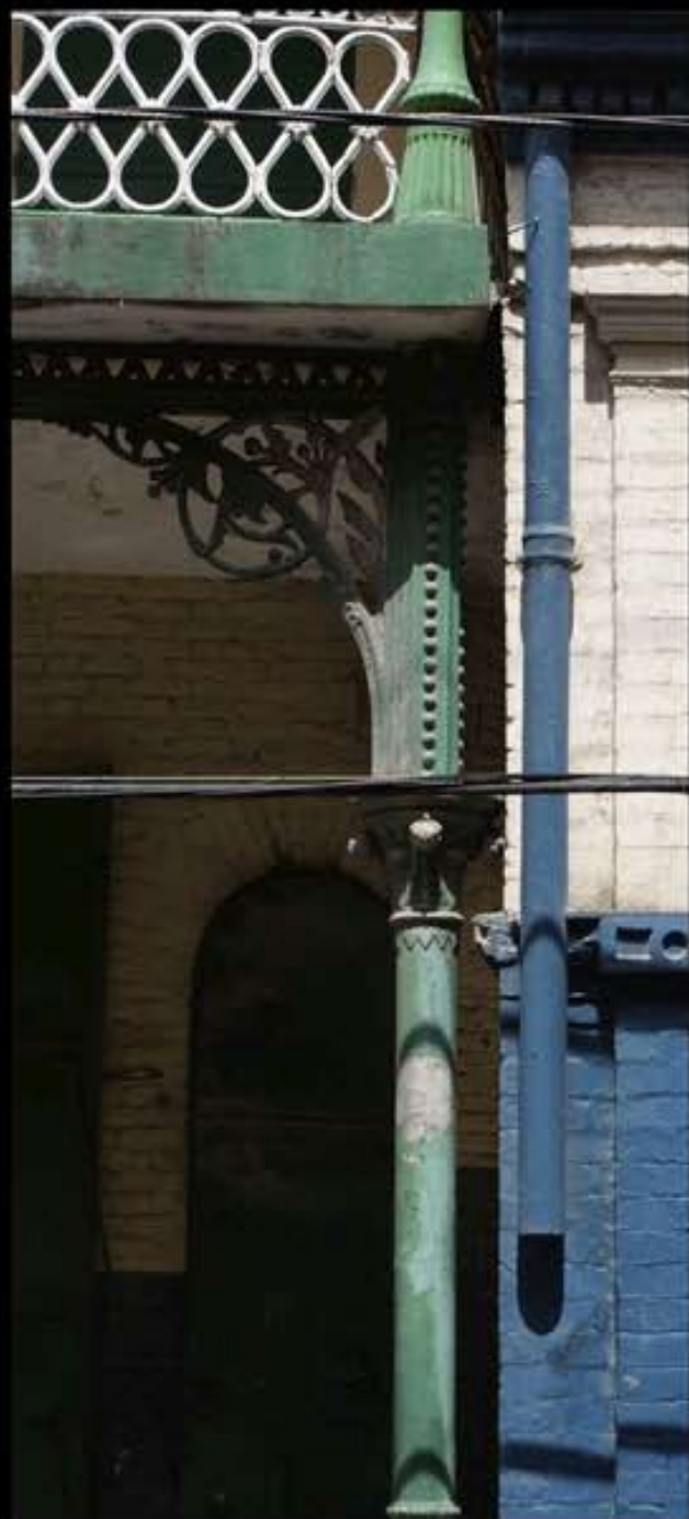
Détail de la structure en fer et fonte
