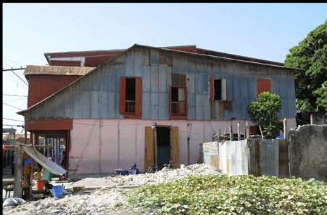
La façade latérale Nord
