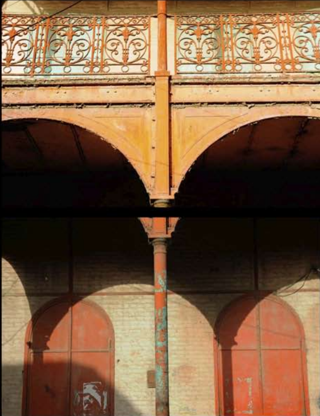
Éléments architecturaux en fer et fonte appliqués à la façade
