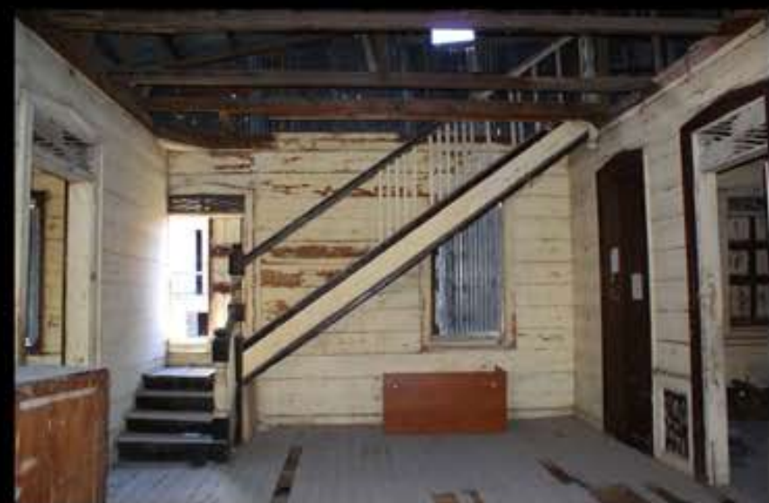
L'escalier d'accès au comble habitable
