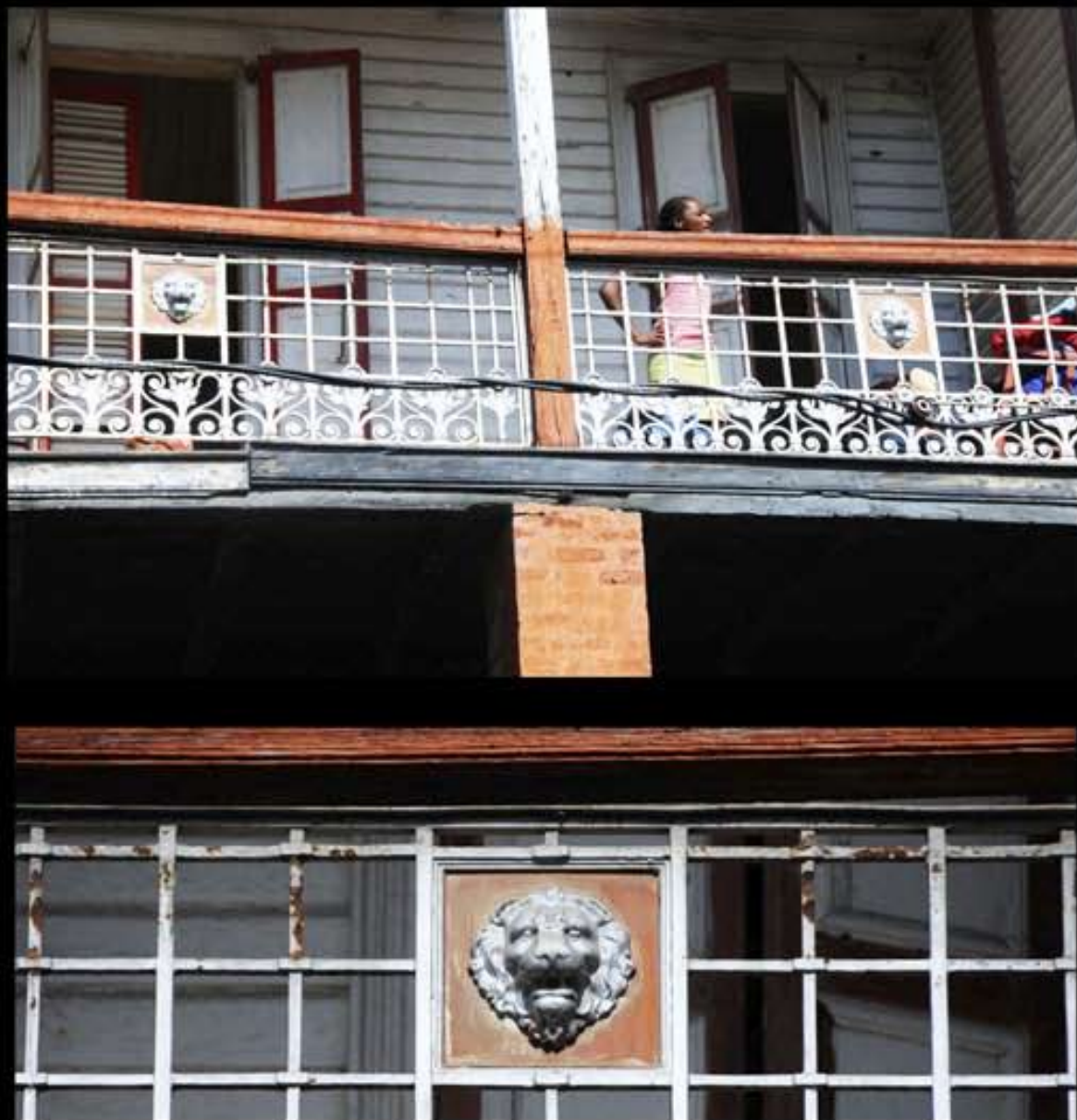
Détail du parapet de la galerie haute
