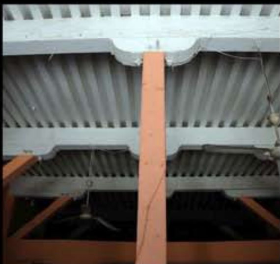
Le plafond de la halle
